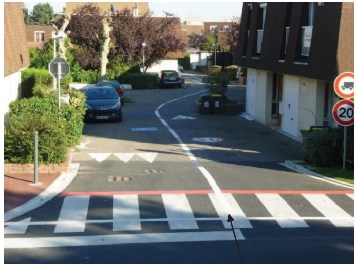
Entrée de rue opposée avec ligne podotactile en « T » guidant les déficients visuels vers les trottoirs de la rue transversale.
