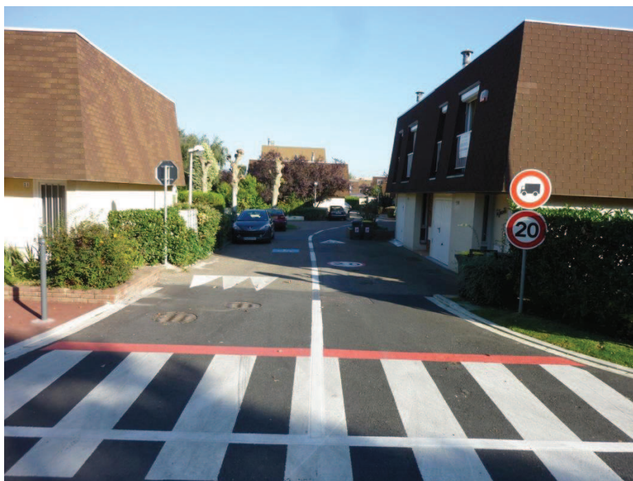
Cette vue de la rue Gabriel Jaillard permet d'apprécier le planning typique de voirie, sans trottoirs ou possibilité d'en aménager.
