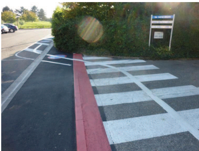
Aménagement de la jonction avec une rue perpendiculaire vers une voie réservée menant au Parc de loisirs (« Coulée Verte »). Continuité de la bande podotactile.
