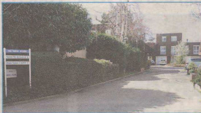
Afin d'indiquer aux véhicules la priorité aux PMR, une ligne sera tracée au milieu de la route et des symboles seront peints.
